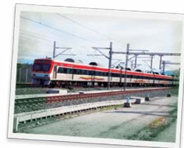
El sistema de suministro eléctrico de un tren recibe el nombre de catenaria.
