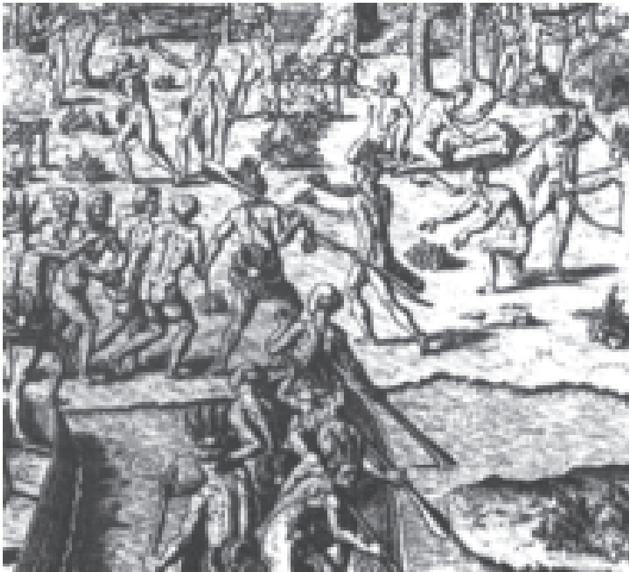
Figura 97. El carácter fiero y belicoso de los indios y la poca explotación agrícola los convirtieron en seres malévolos y peligrosos a los ojos de los puritanos ingleses. Un grabado de 1590 muestra supuestas prácticas de canibalismo entre los nativos
